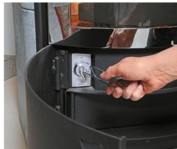
Slika 10; Toplotno moč se določi s količino dodanih polen, le izjemoma z regulacijo zrak (Vir: www.heimwerkerlexikon.selbermachen.de )
