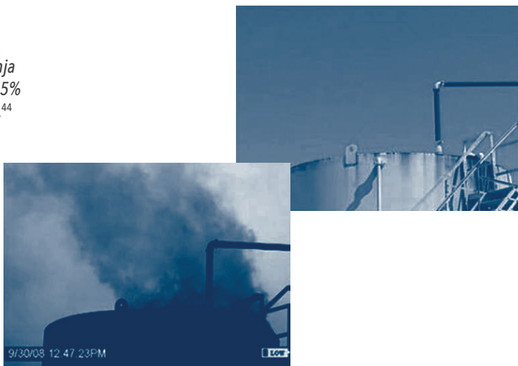
Emisije metana iz rezervoarja za shranjevanje plina, zaznane z infrardečo kamero. Vir: EPA ZDA
